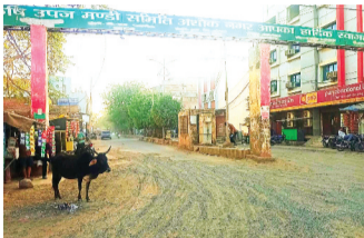
पुरानी गल्ला मंडी मार्ग के साथ मंडी परिसर में भी होगा सड़क का निर्माण
